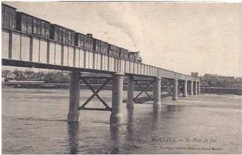
Le pont de fer
