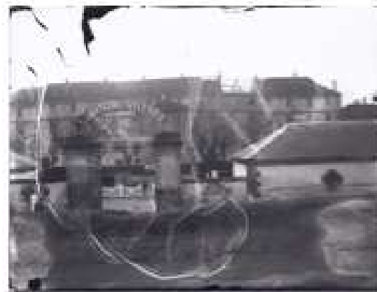
La toiture "Est" défoncée du Quartier Villars
