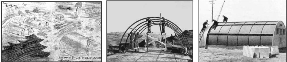
Construction des baraquements (Archives AMFAFL)
