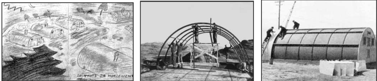
Construction des baraquements (Archives AMFAFL)
