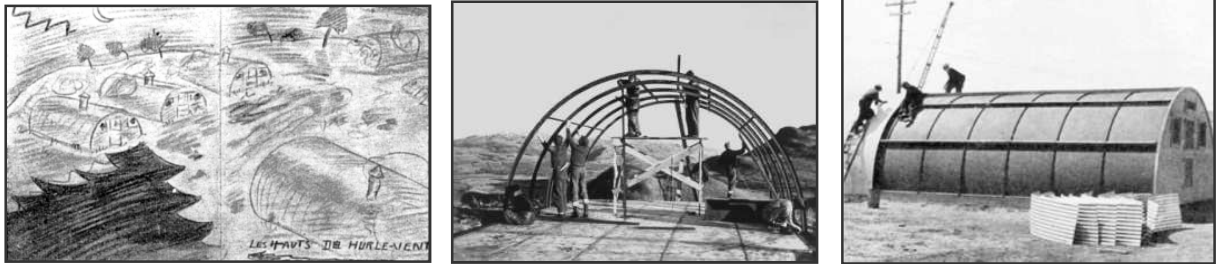
Construction des baraquements (Archives AMFAFL)
