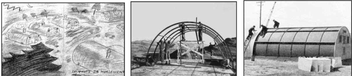
Construction des baraquements (Archives AMFAFL)
