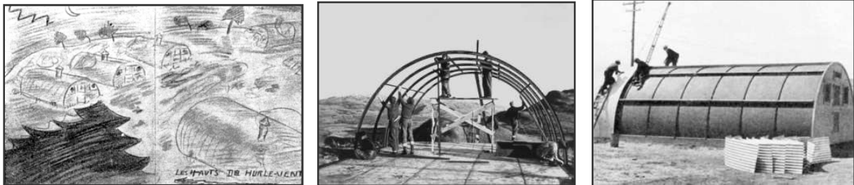
Construction des baraquements (Archives AMFAFL)
