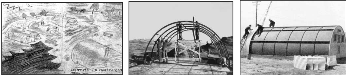
Construction des baraquements (Archives AMFAFL)
