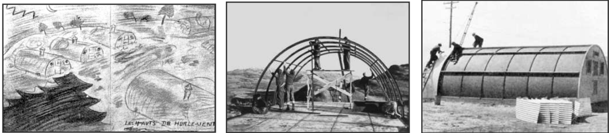
Construction des baraquements (Archives AMFAFL)
