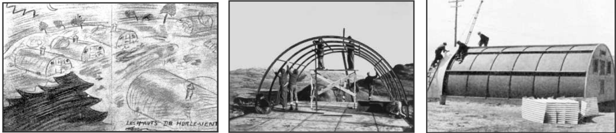
Construction des baraquements (Archives AMFAFL)
