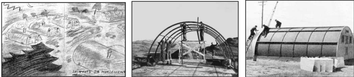
Construction des baraquements (Archives AMFAFL)
