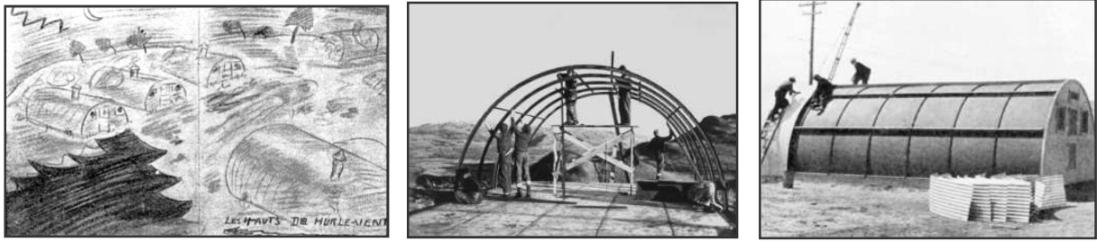
Construction des baraquements (Archives AMFAFL)
