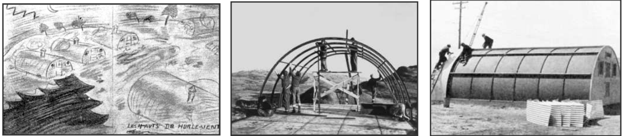
Construction des baraquements (Archives AMFAFL)
