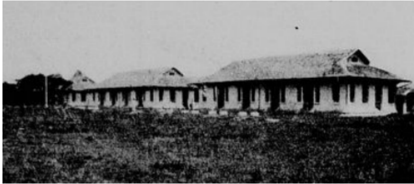
Habitations des agents européens de la Station d'émission de Phu-Tho située à 5 km de la ville de Saïgon. (entreprises-coloniales.fr)
